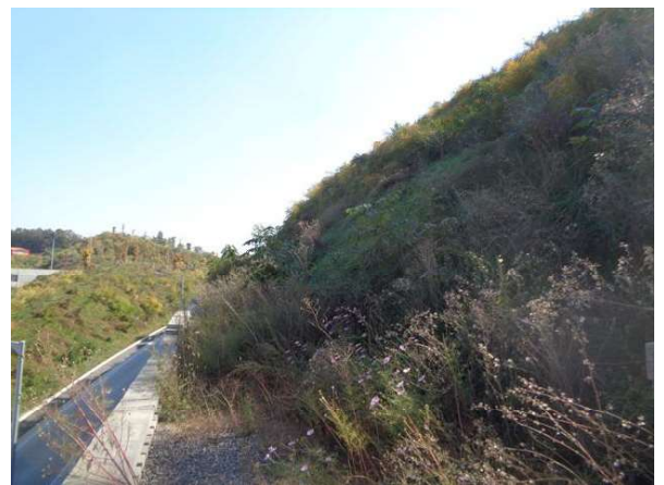
상부 성토부 전경
