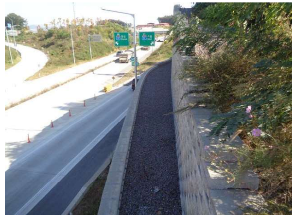
지반 기초부 상태양호
