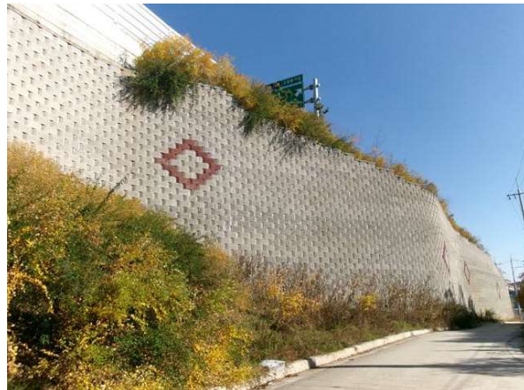
지반 기초부 상태양호
