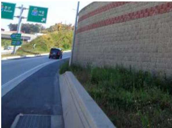
지반 기초부 상태양호
