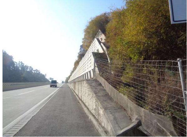
지반 기초부 상태양호
