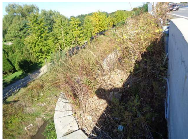
상부 성토부 전경
