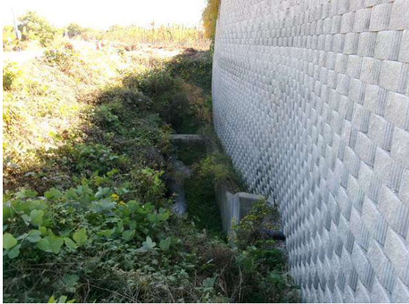
지반 기초부 상태양호
