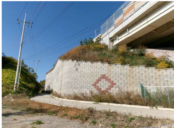
지반 기초부 상태양호
