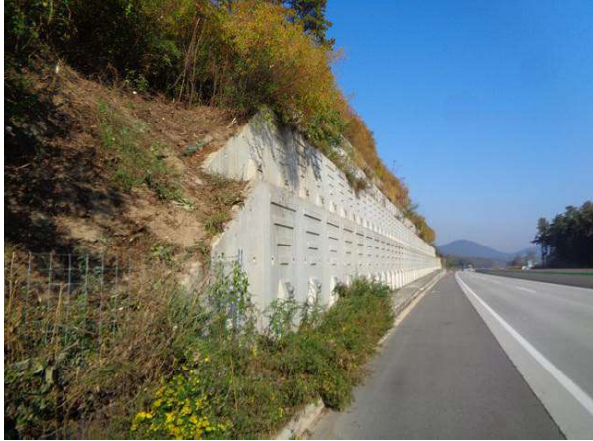
지반 기초부 상태양호
