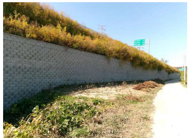
상부 성토부 전경
