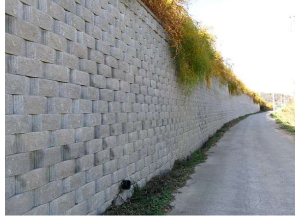
지반 기초부 상태양호
