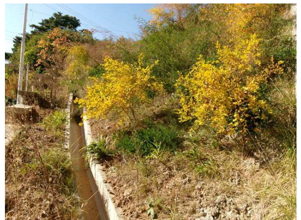
상부 성토부 전경
