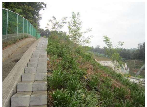
상부 성토부 전경
