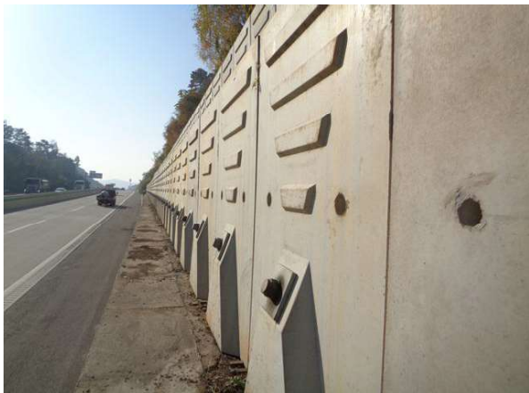
지반 기초부 상태양호
