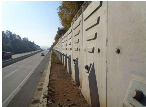
지반 기초부 상태양호
