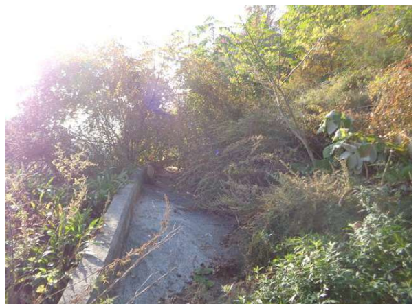
상부 성토부 전경
